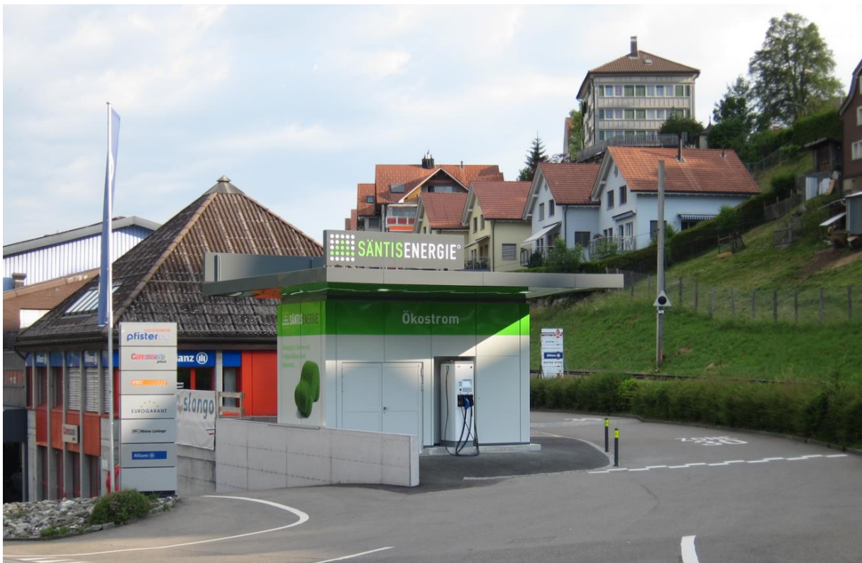
Bild: Weltweit erste Öko-Tankstelle an der Industriestrasse 12 in Herisau.
